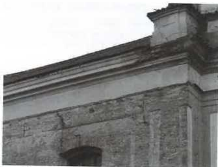
Obr.2: Detail poškození římsy na severní straně
