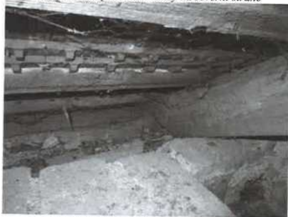
Obr. 3: Námětek krokve, osazený na krkev
