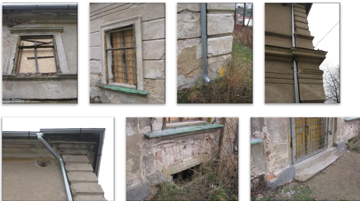
Obrázek 8: Detaily původního stavu fasády
