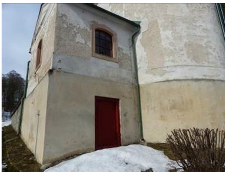
Obrázek 5: Fotodokumentace stavu po provedení sanačních prací – fasáda
