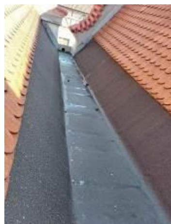
Obrázek 24: Fotodokumentace stavu po provedení stavebních a sanačních prací – zastřešení
