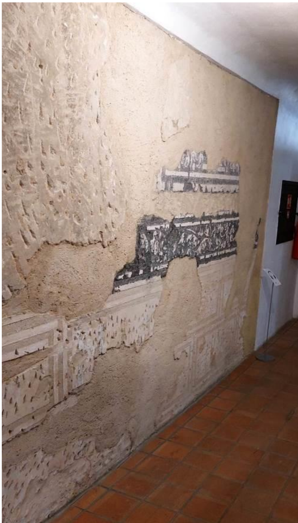
Obrázek 28: Fotodokumentace stavu po provedení stavebních a sanačních prací – renesanční sgrafito
