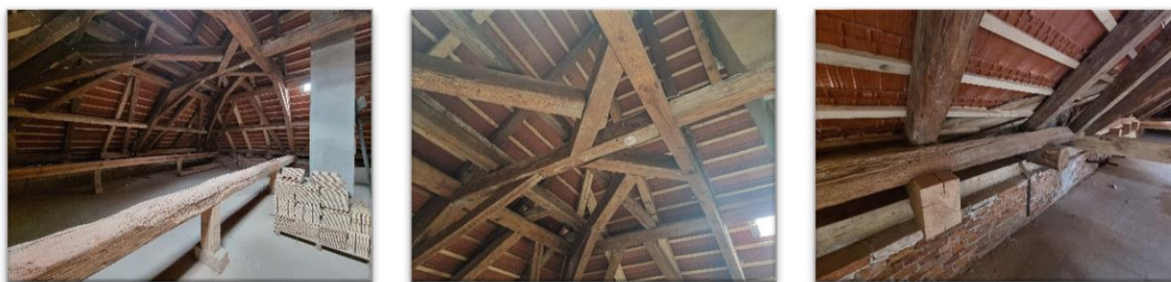
Obrázek 14: Fotodokumentace stavu po provedení stavebních a sanačních prací – půdní prostory
