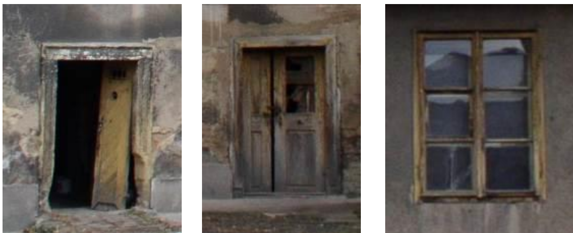
Obrázek 21: Fotodokumentace původního stavu – vnější dveře, okna
