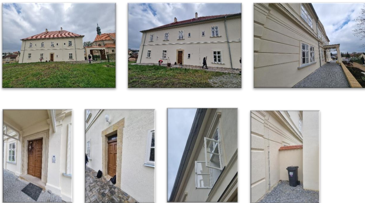
Obrázek 12: Fotodokumentace stavu po provedení stavebních a sanačních prací – fasáda
