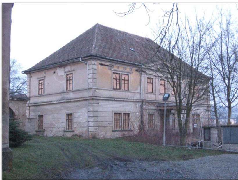
Obrázek 7: Celkový pohled na objekt bývalé fary – původní stav
