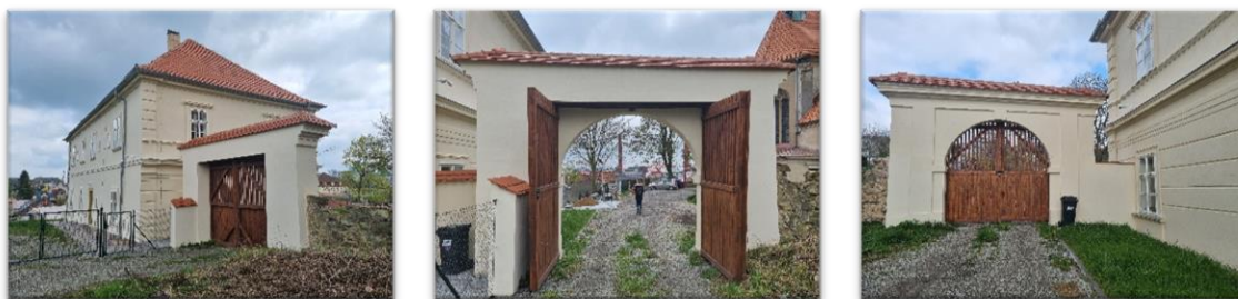
Obrázek 15: Fotodokumentace stavu po provedení stavebních a sanačních prací – brána a oplocení
