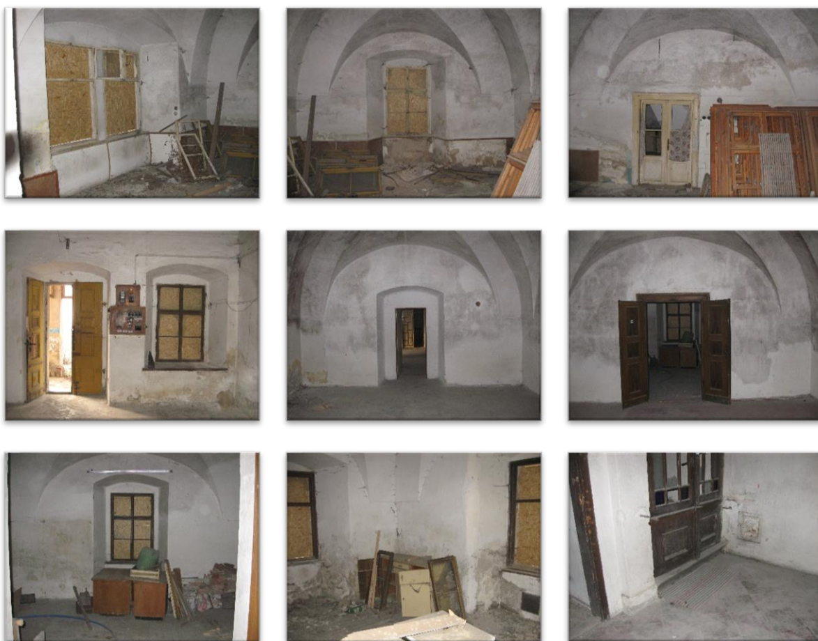
Obrázek 9: Fotodokumentace původního stavu 1. NP
