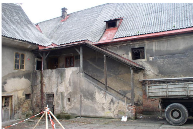
Obrázek 20: Pohled na vnější schodiště do 1. NP
