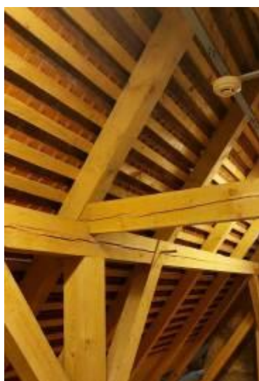
Obrázek 25: Fotodokumentace stavu po provedení stavebních a sanačních prací – krov
