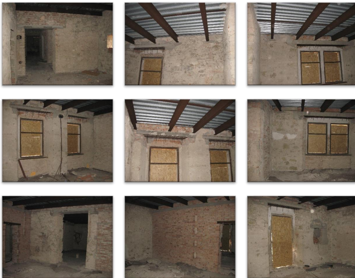
Obrázek 10: Fotodokumentace původního stavu 2. NP
