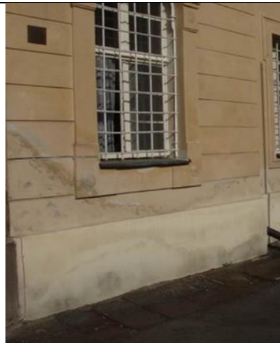
Foto 2: Vlhkostní klín narůstající při napojení zdiva na nasákavý pískovcový portál hlavního vstupu. (autor: L. Balík)
