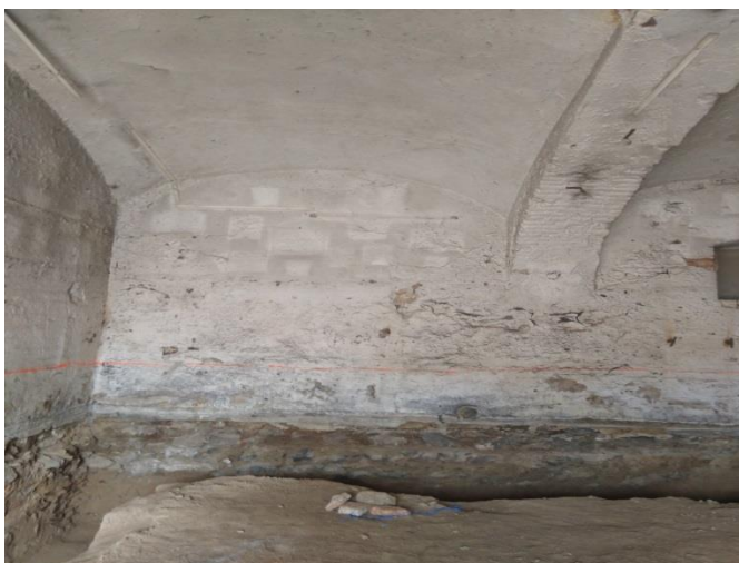
Obr. č. 20: Ukázka cihelné klenby (zdroj: vlastní)
