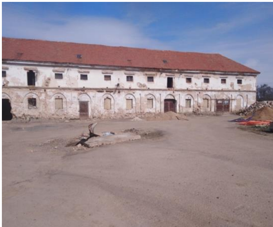
Obr. č. 21: Ukázka oprava vnější fasády (zdroj: vlastní)
