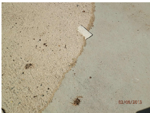
Foto č. 21: Sanace povrchu nepropustným nátěrem (autor: I. Šimůnek)
