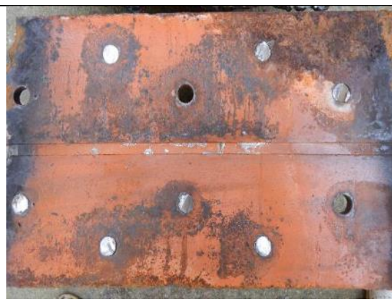
Foto č. 30: Suříkový základní nátěr na dolní pásnici ocelové konstrukce Negrelliho viaduktu v Praze
