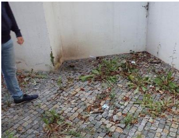
Foto č. 3: Přítomnost vegetace indikuje špatný spád dlažby ke zdivu (autor: L. Balík)
