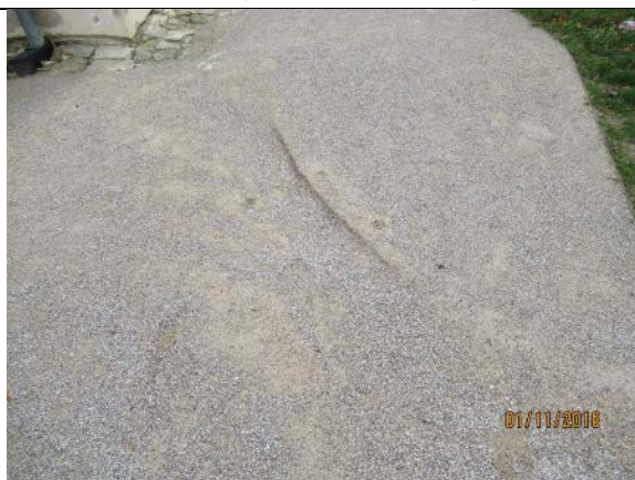
Foto č. 15: Kamenná dlažba – poškození deformací terénu (autor: I. Šimůnek)
