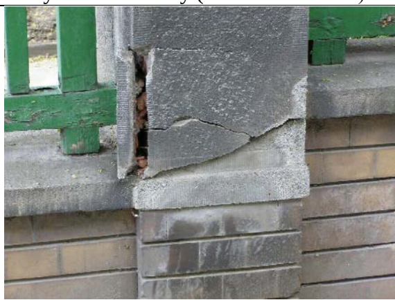
Foto č. 16: Poškození kamenné opěrné zídky tlakem zeminy (autor: I. Šimůnek)
