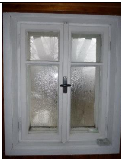
Foto č. 13: Prostředí špalety, přílišná vlhkost, nutná úprava vnitřního mikroklimatu (autor: L. Kudrnáčová)
