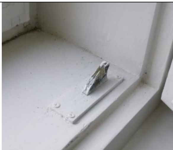
Foto č. 5: Kování, vnitřní zarážka vnějších křídel dvojitých oken (autor: L. Kudrnáčová)
