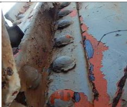
Foto č. 29: Suříkový základní nátěr na svislici konstrukce původní lávky přes plavební kanál v Praze 6 – Bubenči
