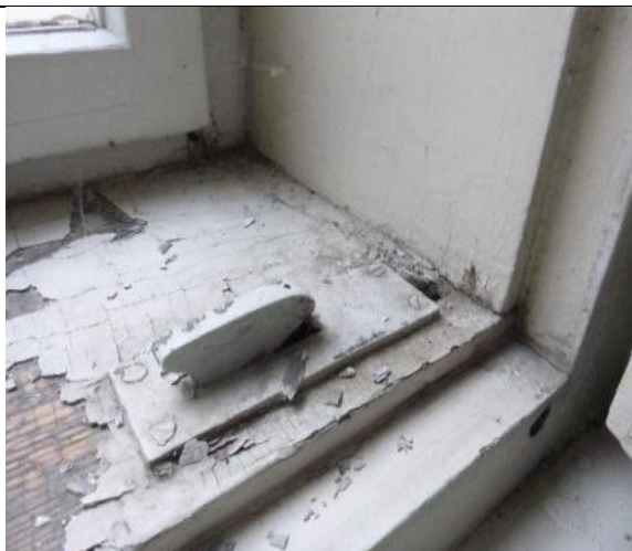
Foto č. 11: Kontrola funkce kování, zarážka vnějšího křídla okna (autor: L. Kudrnáčová)
