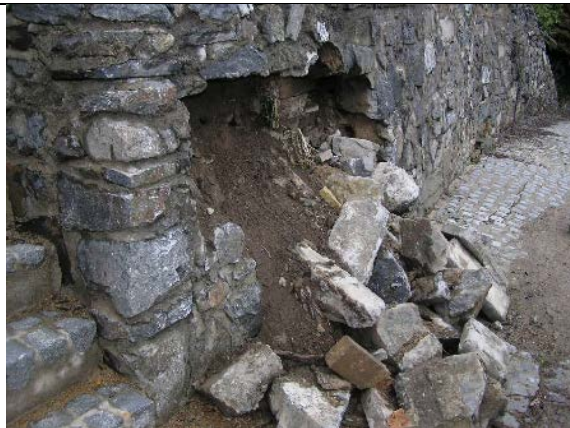
Foto č. 16: Poškození kamenné opěrné zídky tlakem zeminy (autor: I. Šimůnek)
