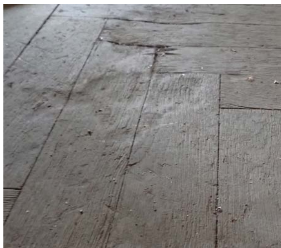
Foto č. 3: Dubové parkety, deformace povrchu mechanickým používáním (autor: L. Balík)
