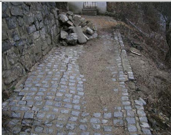
Foto č. 15: Kamenná dlažba – poškození deformací terénu (autor: I. Šimůnek)
