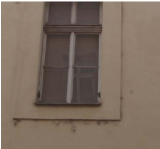
Foto č. 7: Profilovaná šambrána kolem okna na fasádě, přítomnost pavučinek, zašpinění fasády (autor: L. Balík)
