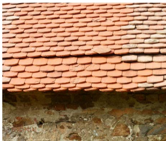
Foto č. 6: Degradace pálené krytiny účinkem mrazu (autor: I. Šimůnek)
