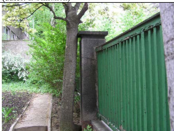
Foto č. 18: Mrazové narušení zdiva plotového sloupku, degradace nátěru dřevěných prvků (autor: I. Šimůnek)
