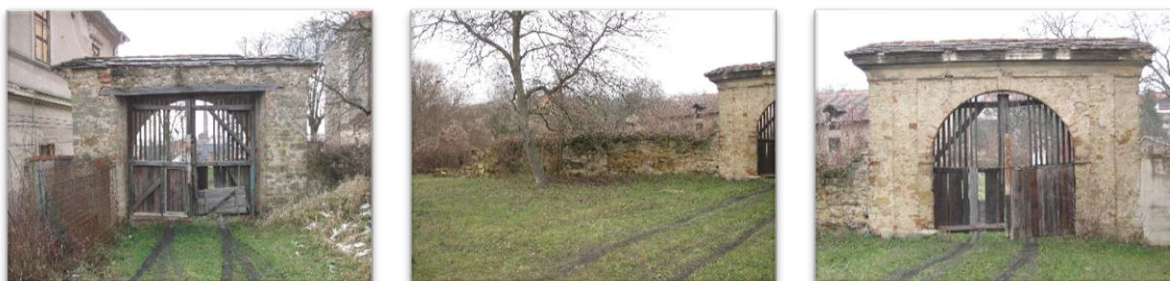
Obrázek 5: Fotodokumentace původního stavu brány a oplocení
