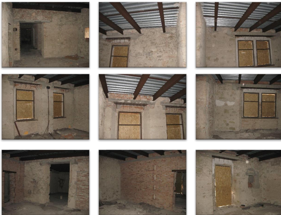
Obrázek 4: Fotodokumentace původního stavu 2. NP
