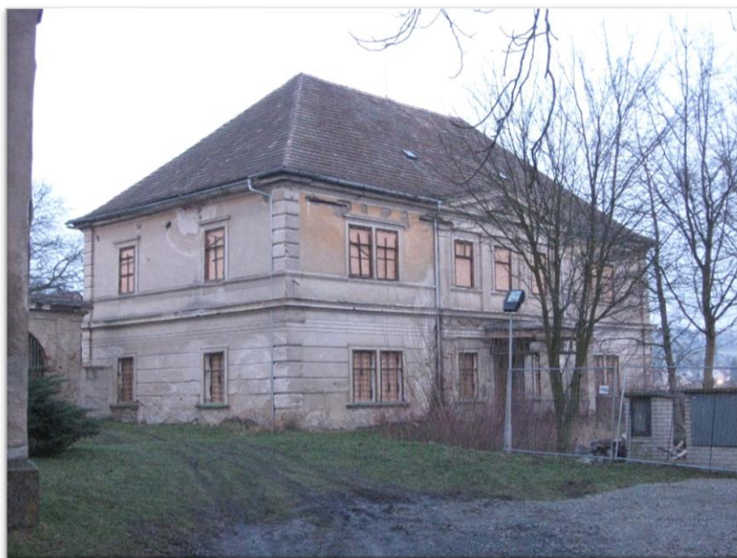
Obrázek 1: Celkový pohled na objekt bývalé fary – původní stav
