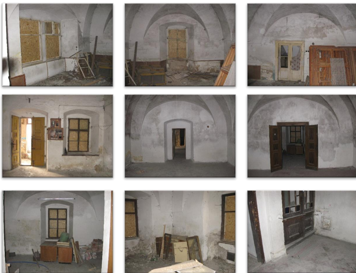
Obrázek 3: Fotodokumentace původního stavu 1. NP
