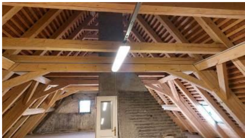
Obrázek 6: Fotodokumentace stavu po provedení stavebních a sanačních prací – zastřešení
