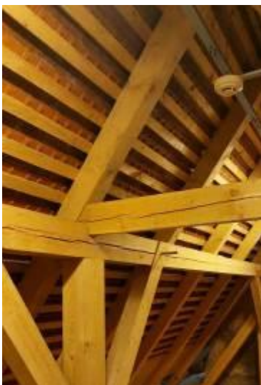
Obrázek 7: Fotodokumentace stavu po provedení stavebních a sanačních prací – krov
