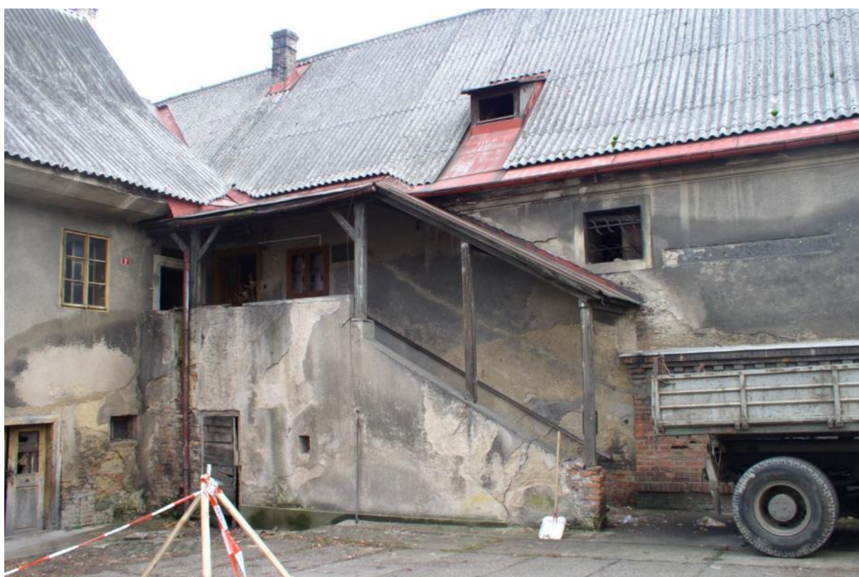
Obrázek 2: Pohled na vnější schodiště do 1. NP
