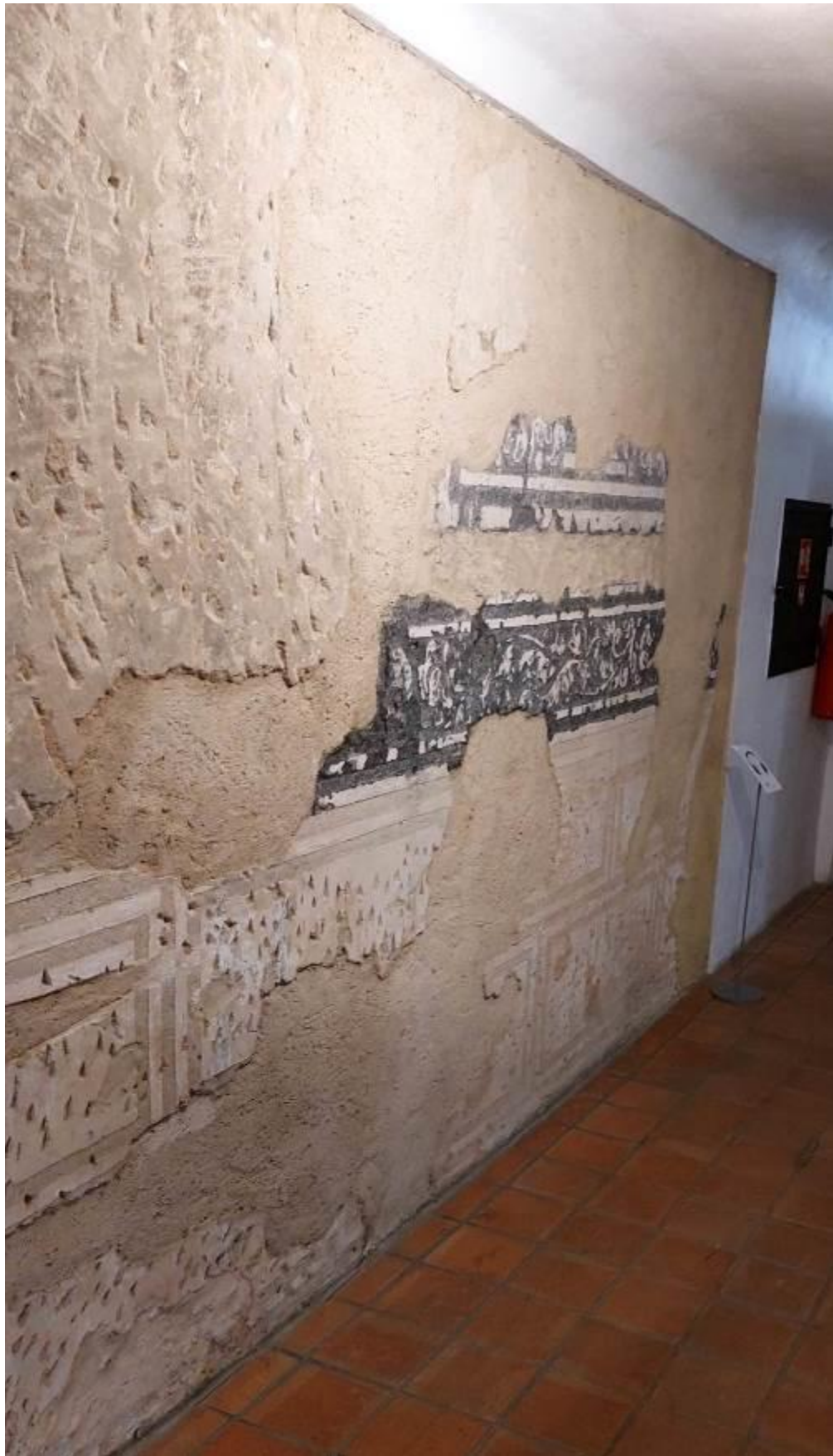
Obrázek 10: Fotodokumentace stavu po provedení stavebních a sanačních prací – renesanční sgrafito
