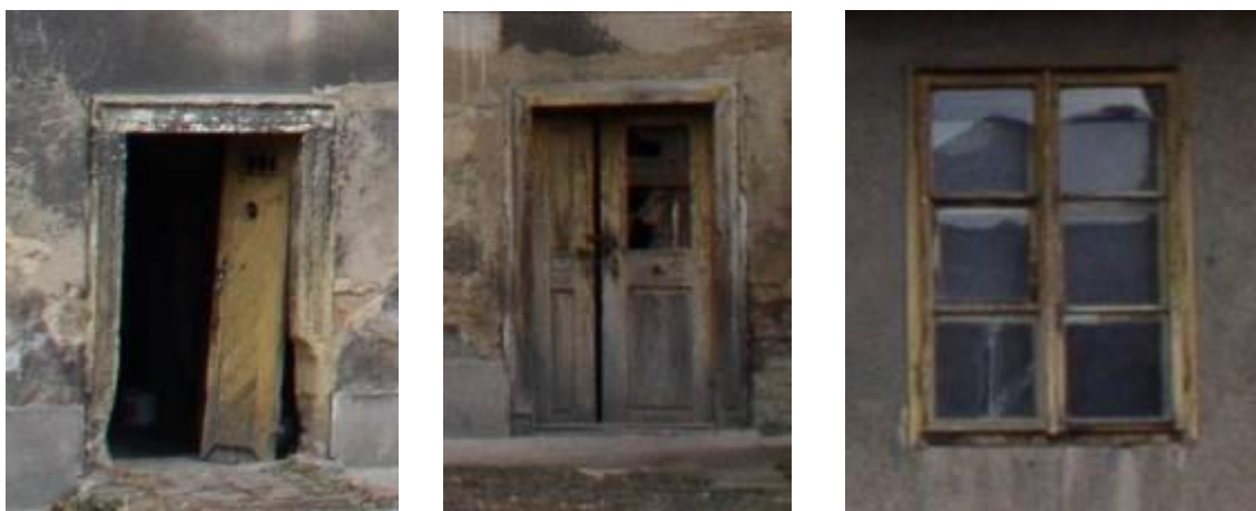
Obrázek 3: Fotodokumentace původního stavu – vnější dveře, okna
