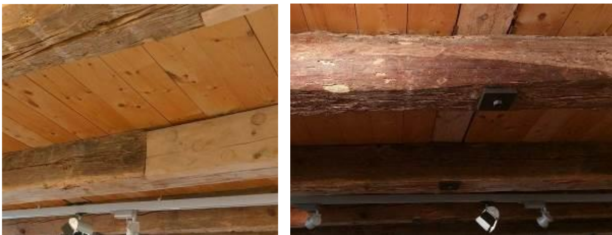
Obrázek 8: Fotodokumentace stavu po provedení stavebních a sanačních prací – dřevěný strop
